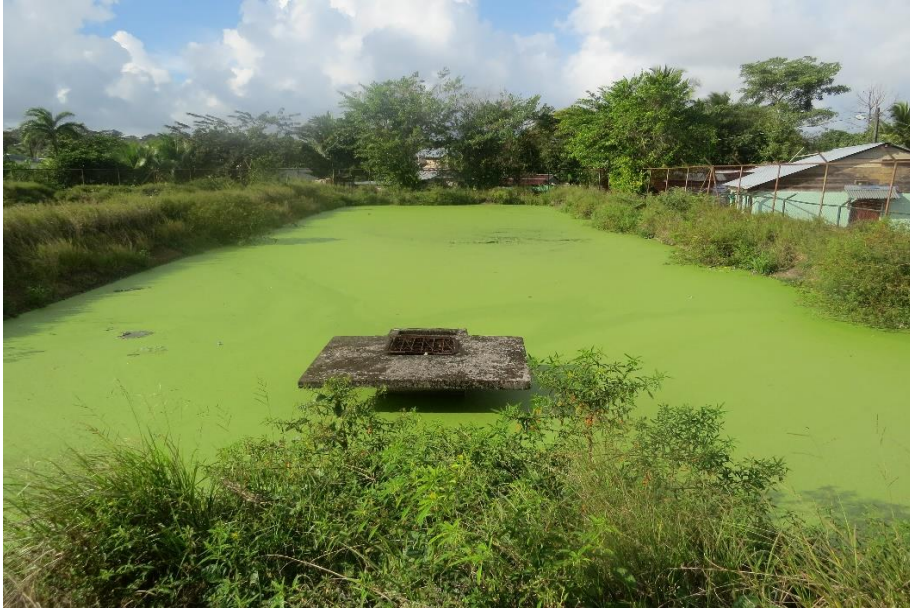
Ilustración 11. Tercera pila de oxidación. Se observa 100% eutrofizada y cubierta por vegetación
