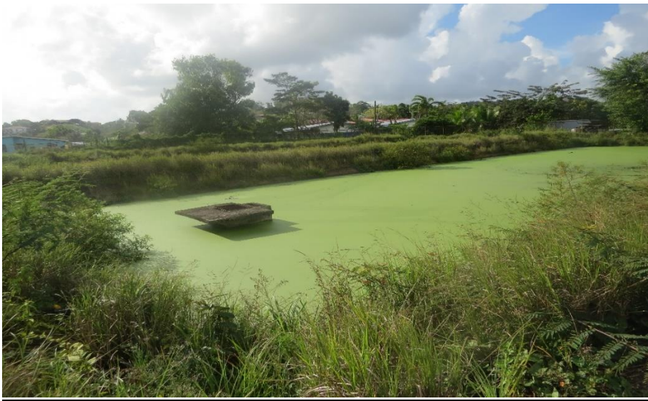
Ilustración 12. Tercera laguna de oxidación, vista lateral. Se observan las viviendas a menos de 20 metros del perímetro.
