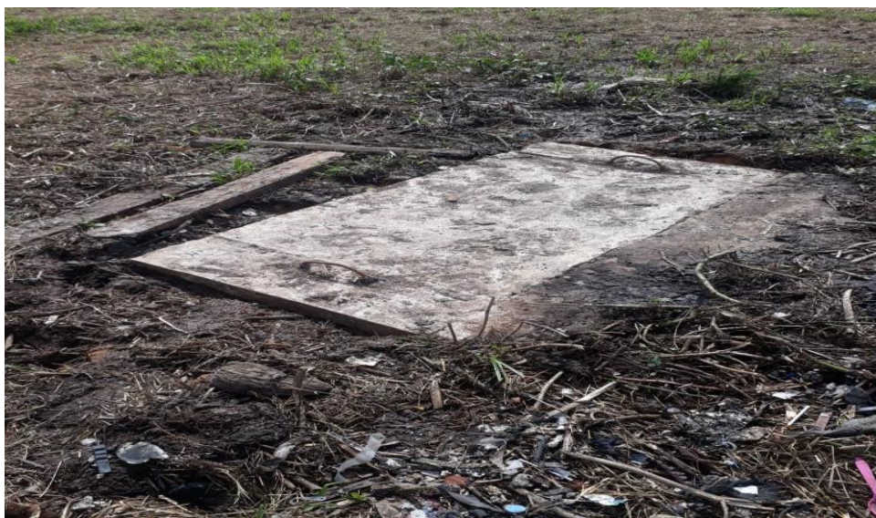
Ilustración 18. Caja de registro sellada después de haber estado rebalsada.
