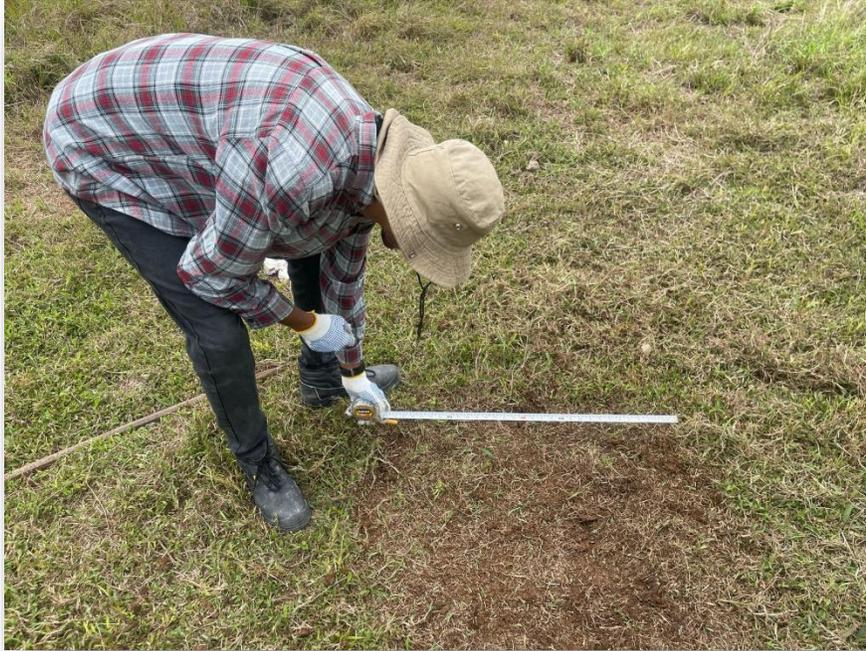
**Nota:** Realizando mediciones de dimensiones para posteriormente proceder con la excavación de la calicata.
