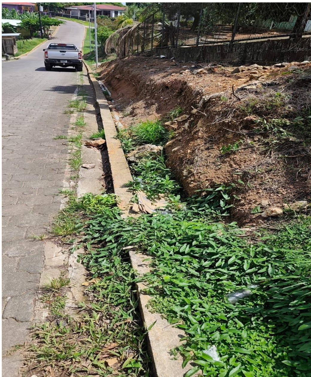
Figura 23. Punto de descarga del efluente hacia el drenaje pluvial exterior del internado de BICU.
