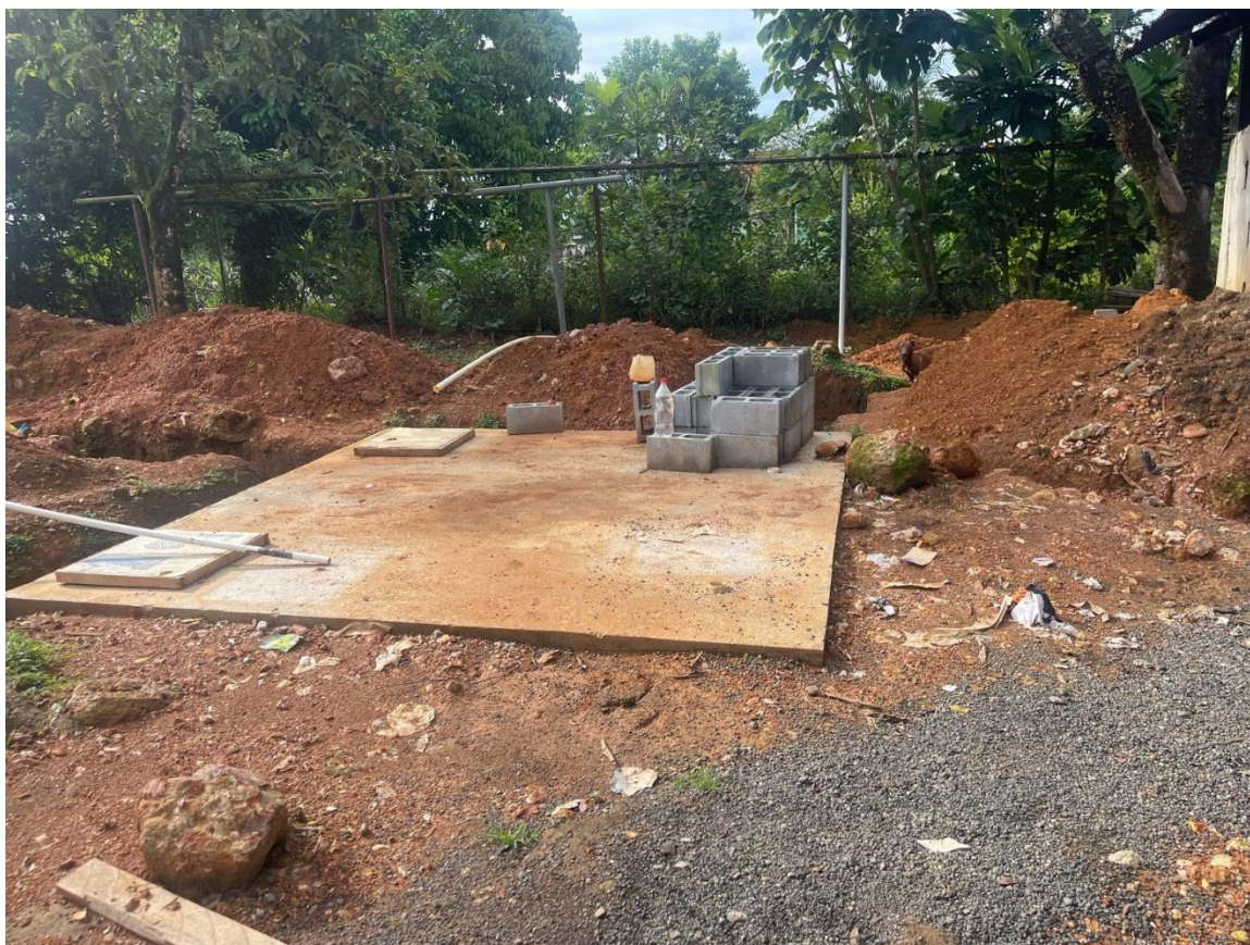
Figura 17. Losa de base y área de implantación para la construcción del nuevo sistema de fosa séptica en el internado de BICU.
